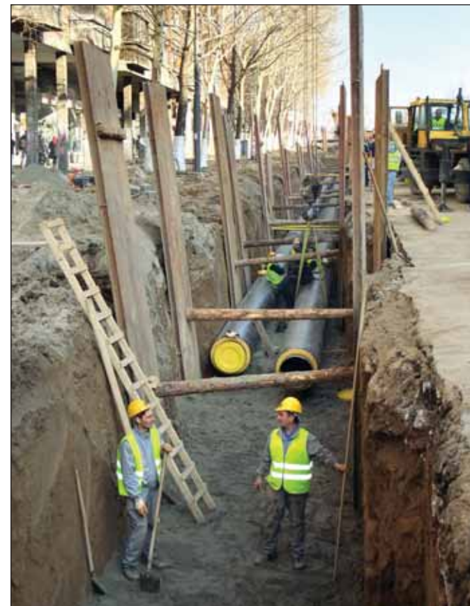
Изградња новог магистралног топловода
